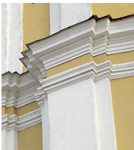
Рис. 3.33. Раскреповка на фасаде церкви Воздвижения Святого Креста в Лиде
